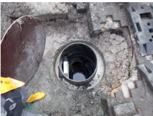
Verfüllung des Ringraums mit hochsulfatbeständigen Zement
