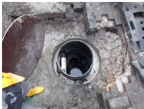
Einbau Schachtkonus
