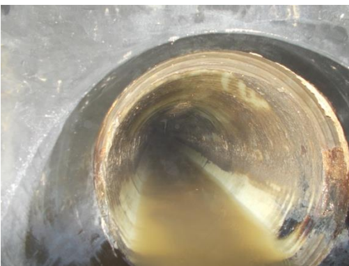
Altrrohr vor der Anbindung
