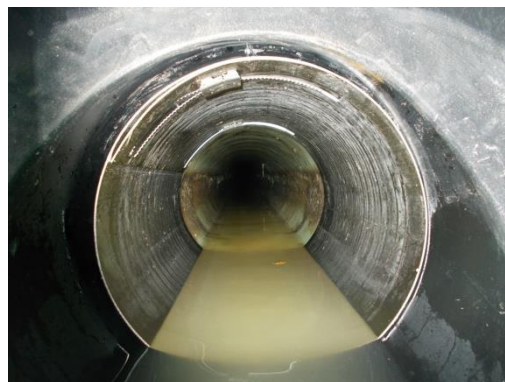
Anschluss mit Anbindung
