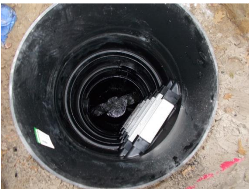
Einbau Schachtmodule
