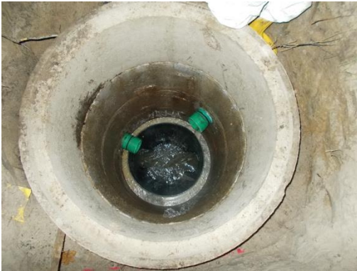
Einbau Schachtunterteil mit hochsulfatbeständigem Spezialmörtel
