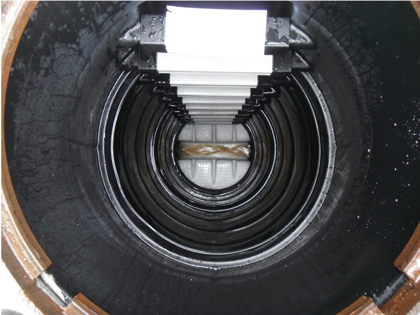
Sanierter Schacht
