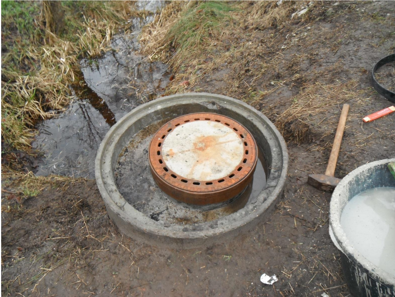
Lastentkoppelte Abdeckung
