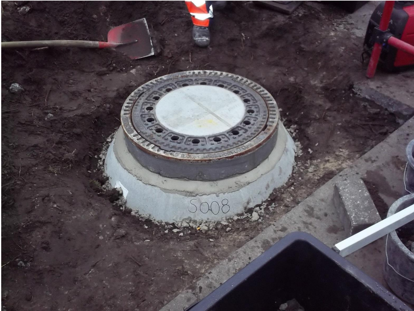
Lastentkoppelte Abdeckung
