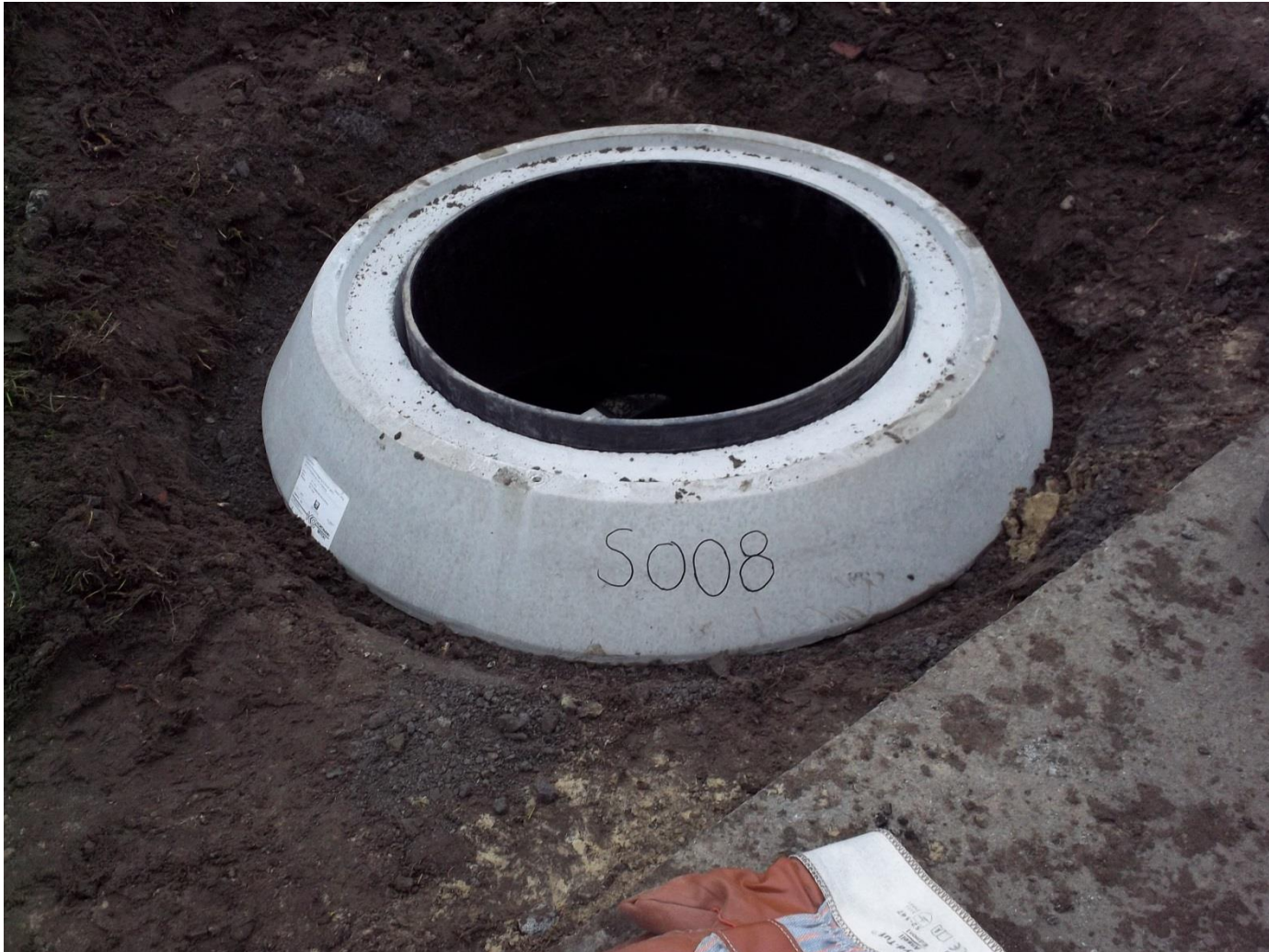
Lastentkoppelte Abdeckung
